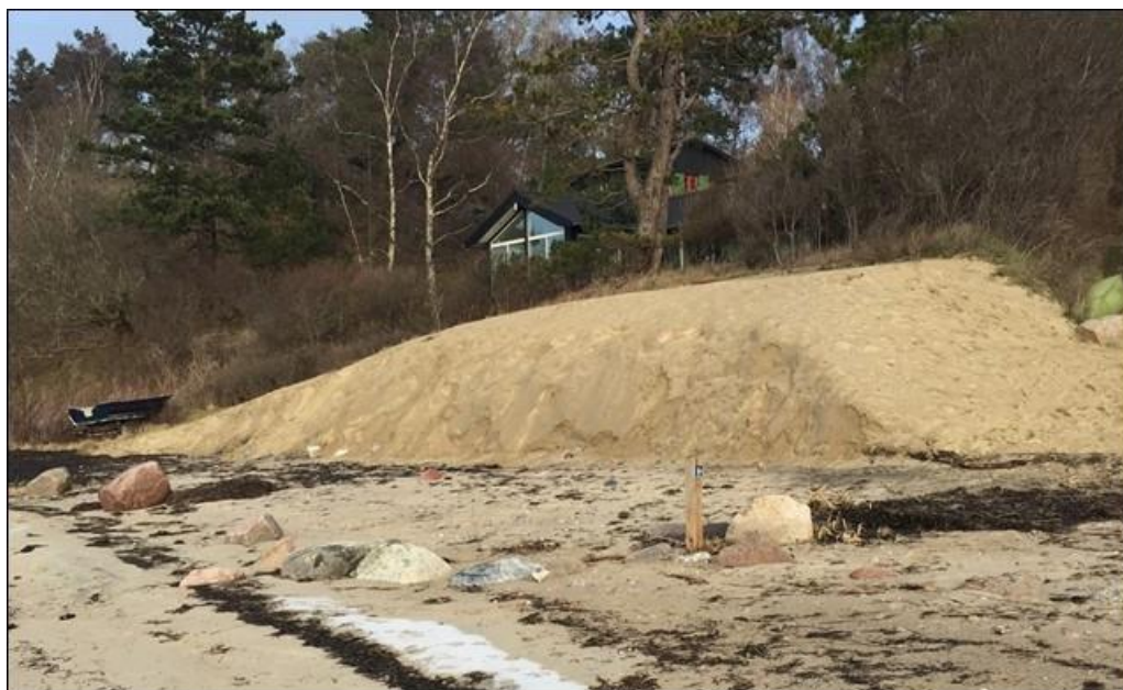
Figur 4: Foto fra januar 2019, der viser den eksisterende store sandbuffer efter erosion fra højvande. Foto fra samme vinkel som Figur 1.
