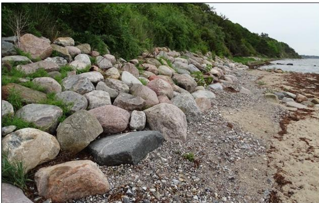
Figur 5: Foto fra 2017 af sikret skræntfod på naboejendom.
